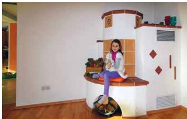
Gut gelüftet und gemütlich warm: Eine solare Lüftung lässt sich einfach nachrüsten, ist mit jedem Heizsystem kombinierbar und fördert ein hygienisches Raumklima. Foto: djd/Grammer Solar
